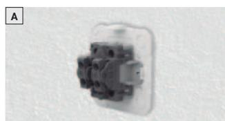
Application du mécanisme sur le mur
